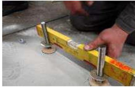
1. Schrauben Sie die unteren Verstellmuttern auf die Bodenanker und legen Sie die Unterlegscheiben auf die Muttern.
